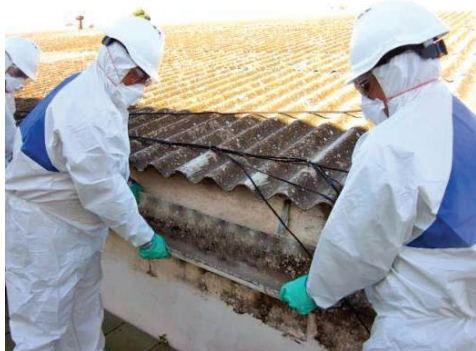
RETIRO DE ASBESTO
