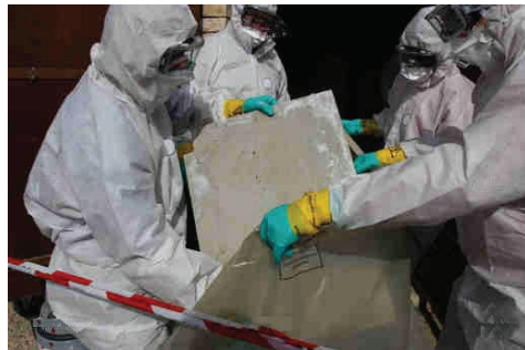
RETIRO DE ASBESTO
